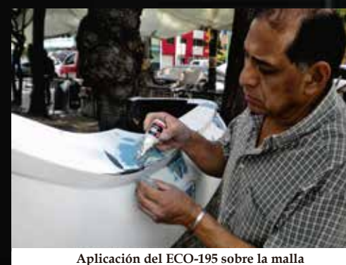
Aplicación del ECO-195 sobre la malla
